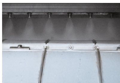
Siebreinigung mit Luft-/Wasserspülung
