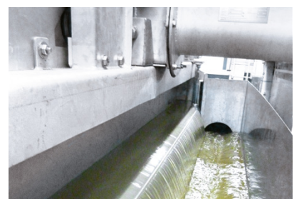
Ablauf des gesiebten Abwassers
